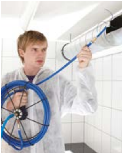
De roterende kunststof draden ondersteunen de reiniging
