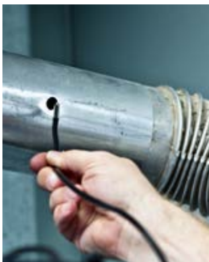
Inspecties door openingen met een werklengte tot 3 m
