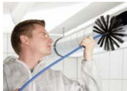
Lichtgewicht en zeer flexibel inzetbaar dankzij gebruik met accuboormachine
