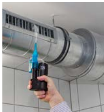
Functionele controle luchtrooster
