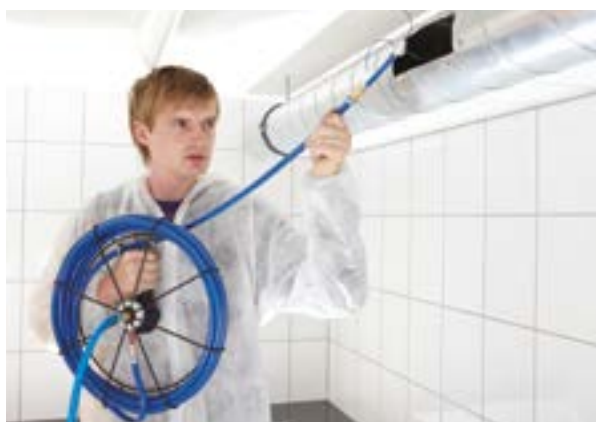
Persluchtreiniging bij rond leidingwerk met de helikoptersproeier
