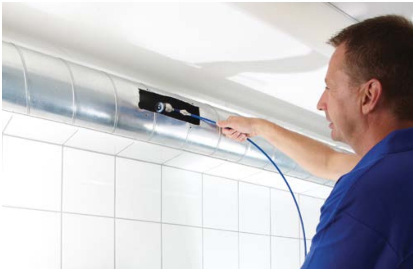
Video-inspectie met het Wöhler VIS 350 video-inspectiecamerasysteem
